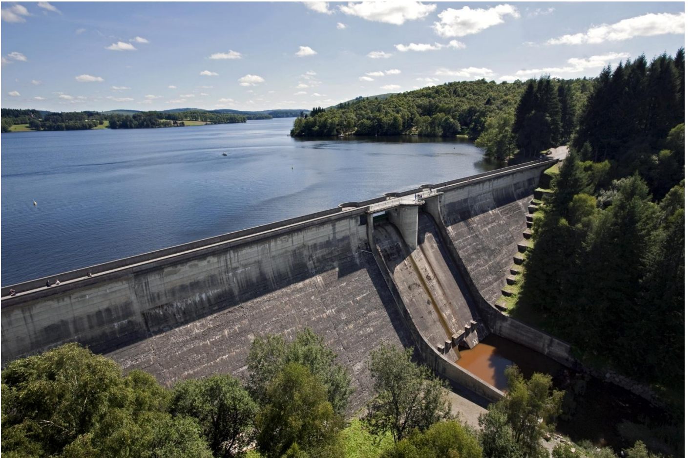
Barrage hydraulique de Vassivière. Cliché EDF.
