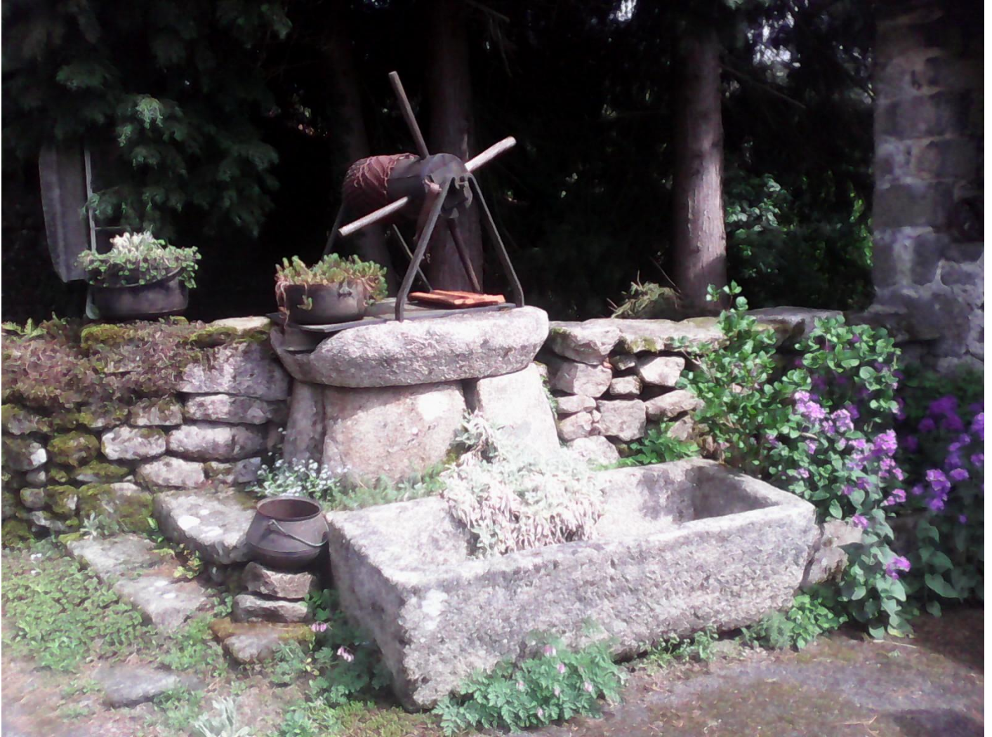
Châtenet-Maussan, puits à treuil et à chevilles et abreuvoir.
