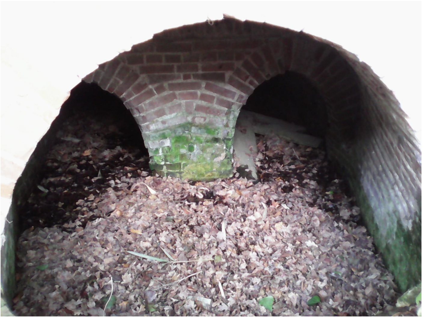
Ouverture du foyer sous le four.
