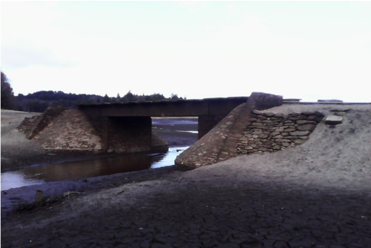
Le pont lors de la vidange de 2017 (photo du 29 novembre 2017).
