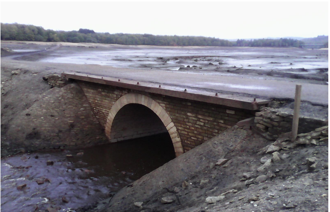
Le même pont lors de la vidange de 2017 photo du (21 octobre 2017).
