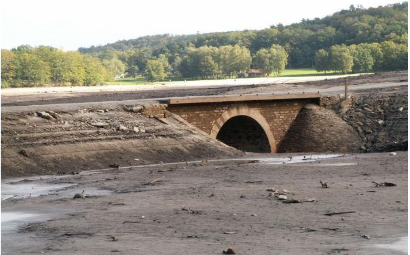
Le pont de la Breuilhe lors de la vidange de 2006 (photo du 26 octobre 2006).
