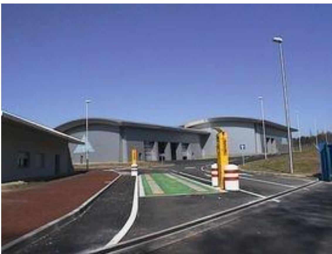
L'entrée du centre de recyclage. Au premier plan (en vert) la bascule. Cliché Limoges Métropole.
